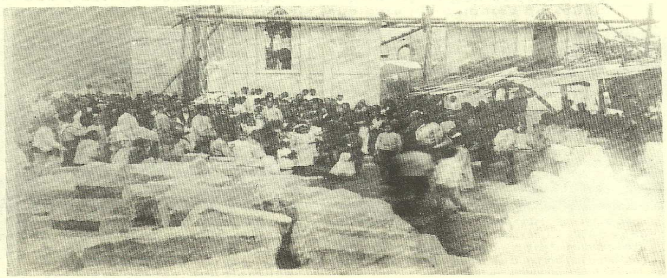
VI.- Construcción del templo en el mineral de San Andrés de la Sierra.
