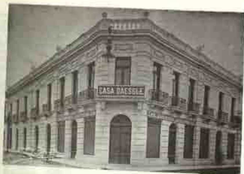
Esquina Victoria y 5 de Febrero. Construido hacia finales del siglo XIX este edificio tiene el aire peculiar, sobrio, los que emplean en su ornamentación las juntas rehundidas en hilados horizontales que se continúan sin interrupción en las dovelas, elemento característico del estilo Luis XIV. Incendiado en 1913 a la entrada de las tropas revolucionarias, y luego reparado, respetando en parte el original. Entre las reformas que se hicieron la más sustancial es la de haber desdenado el ochovado, rectificando el ángulo de la esquina. Se suprimieron también las balaustradas y jarrones que remataban el fidejo. En tanto que las guirnaldas que adornaban el paño superior de las ventanas del segundo cuerpo se sustituyeron por coronas. Actualmente lo ocupa La Escolar, papelería.
