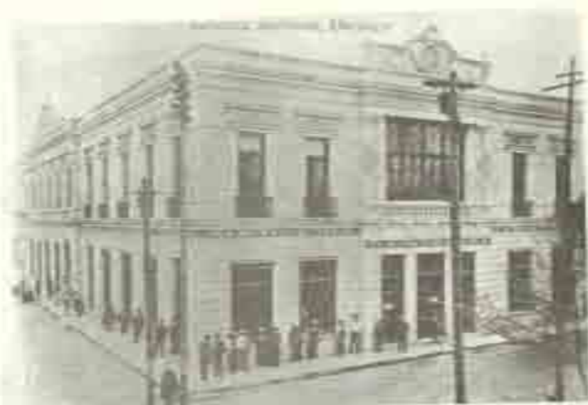
Esquina Constitución y 5 de Febrero (donde hoy está el Banco Nacional de México).
